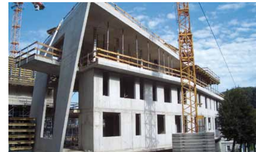
Die Bauarbeiten bei der ehemaligen Sternbrauerei schreiten rasch voran.
